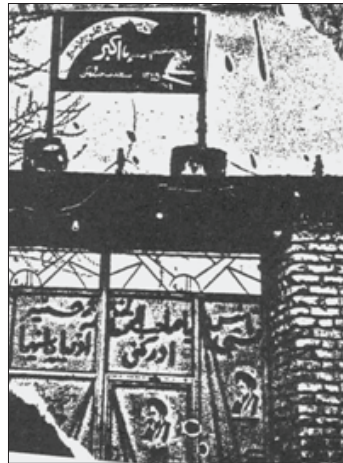
حسینیه آذربایجانی های گنبد آماج گلوله های ستاد خلق ترکمن
